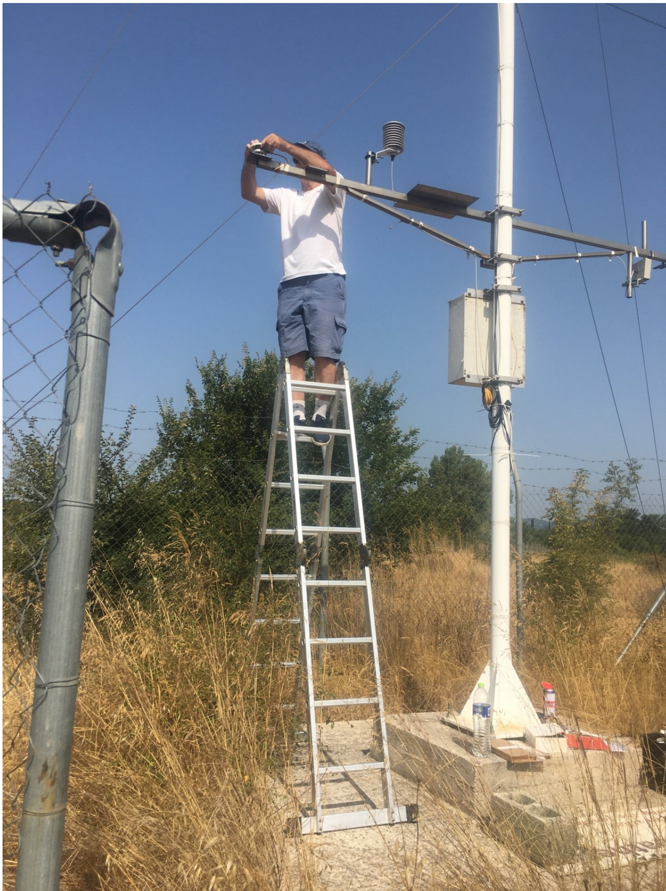
Εικόνα 1.2-3: Απο τα τεχνικά έργα στον σταθμό CRF-2 (26/7/2021).
