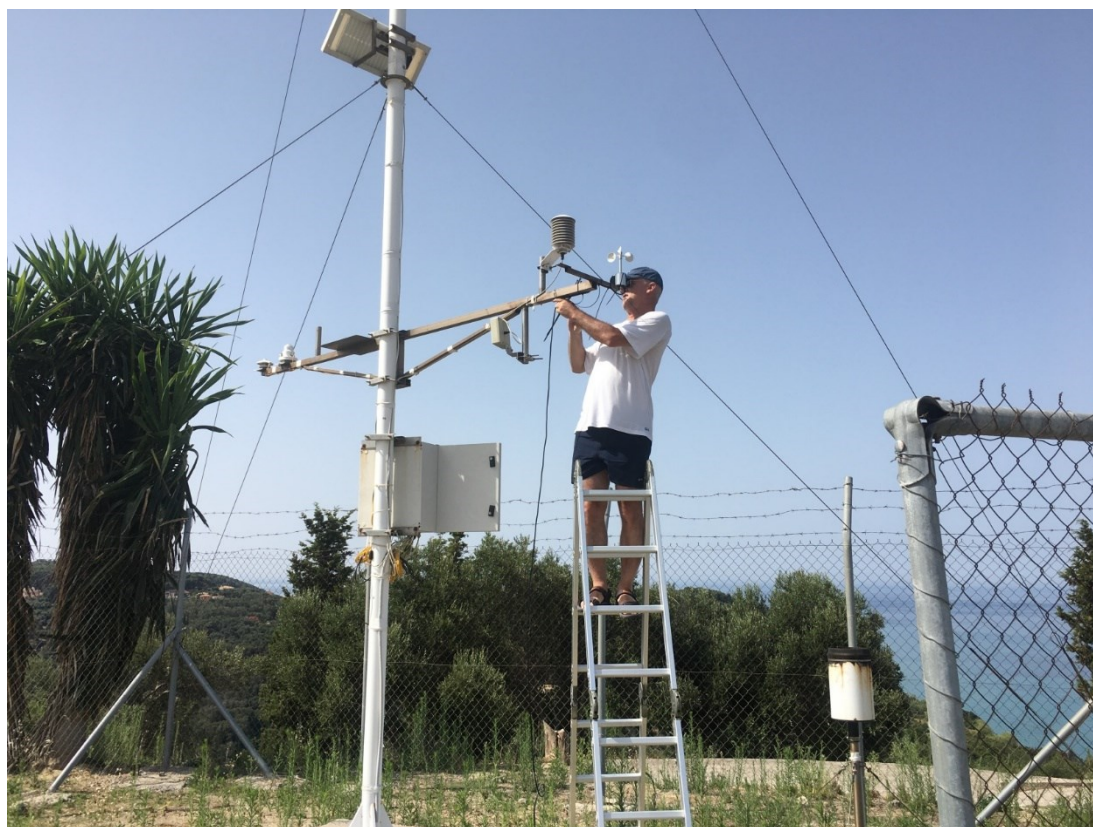
Εικόνα 1.2-2: Απο τα τεχνικά έργα στον σταθμό CRF-1 (στις 27/7/2021).
