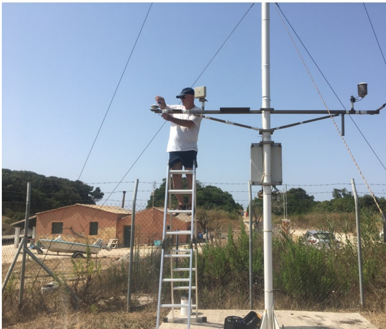
Εικόνα 1.2-7: Απο τα τεχνικά έργα στον σταθμό CRF-3 (στις 28/7/2021).
